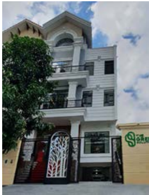
Văn phòng công ty Green Solutions Quận 7, Thành phố Hồ Chí Minh
